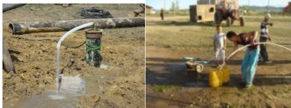
食水支援の井戸掘削活動
